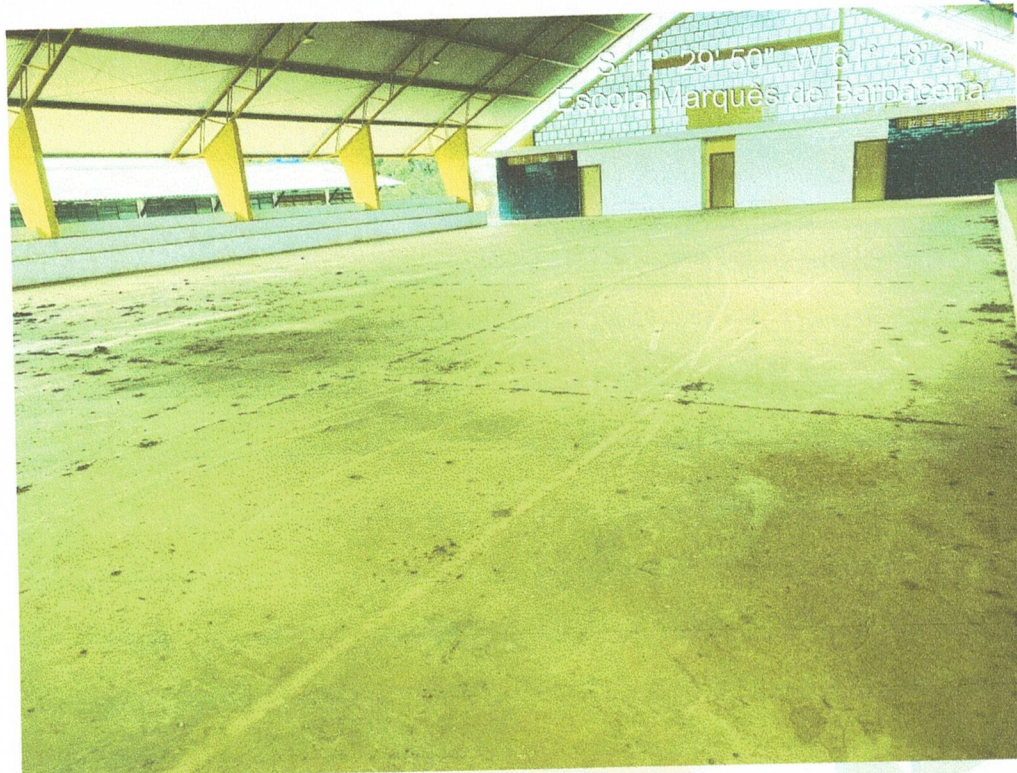
Vista interna (falta a conclusão da pintura epoxi do piso, a instalação dos alambrados, traves e gol)
